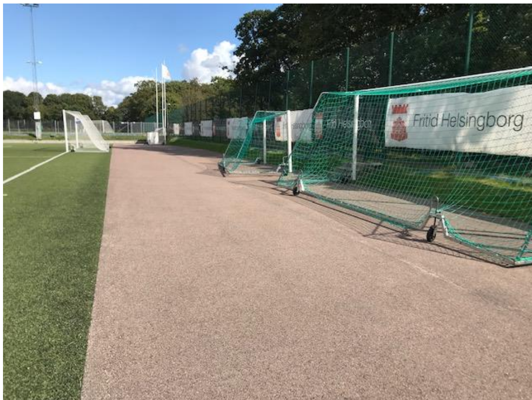
Figur 6.12. Yta runt konstgräsplan för återföring av granulat (Bildkälla: Unisport.se, hämtad 2022-11-25)
