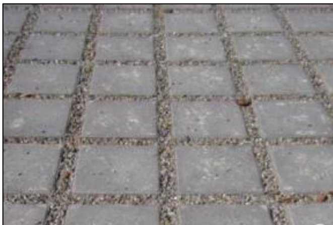
Figur 6.4. Exempel på genomsläpplig betongbeläggning med grusfogar. (WRS, 2015)
