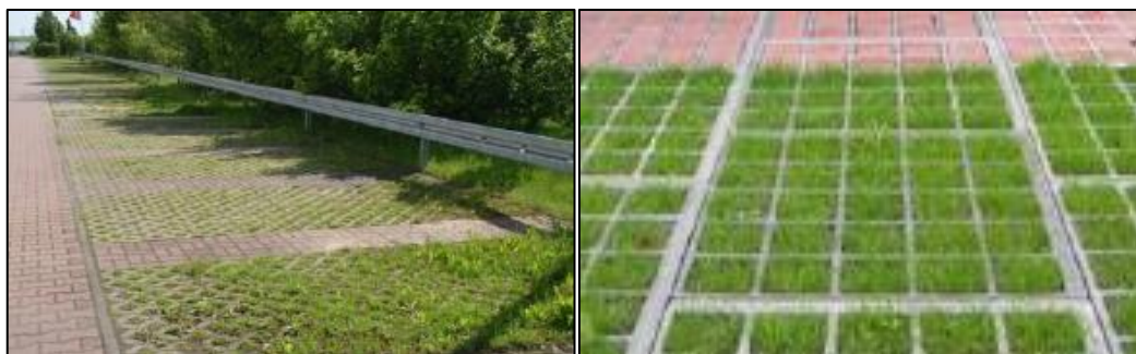
Figur 6.5. Exempel på genomsläppliga beläggningar med gräs. (WRS, 2015)
