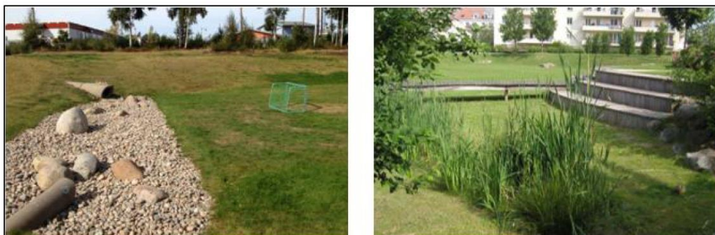
Figur 6.2. Torr damm som används som lekplats till vänster i bild. Torr damm som har integrerats i gestaltningen av området till höger i bild. (Svenskt Vatten Utveckling, 2019)
