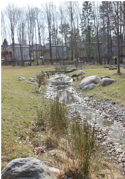
Dagvattenhantering i svackdike.
