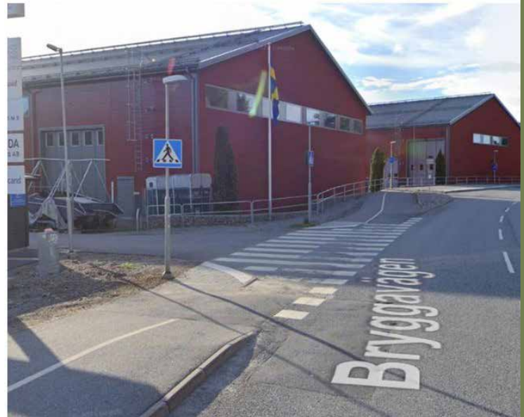
Figur 63. Nuvarande passage vid infart till marinan. Där gång- och cykelvägen korsar Ångkvarnsvägen finns det ingenting som visar att bilvägen korsar en gång- och cykelväg. Det är en otydlig korsning för samtliga trafikanter.
