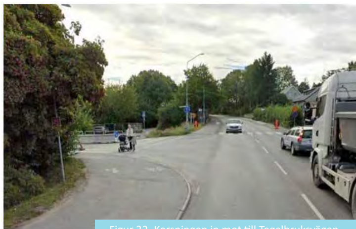
Figur 32. Korsningen in mot till Tegelbruksvägen till vänster. Skymmande vegetation intill väg och GC-väg.
