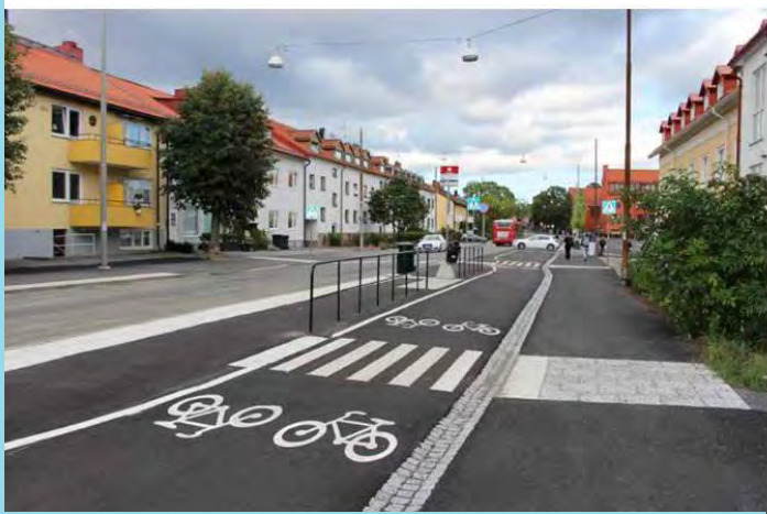
Figur 34 . Tydlig uppdelning mellan gående och cyklister. Exempel från ny cykelbana längs Gamla Huddingevägen (Stockholms stad 2018).
